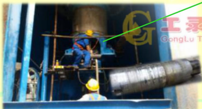
塔搅拌器盘根添加扇形引流装置
